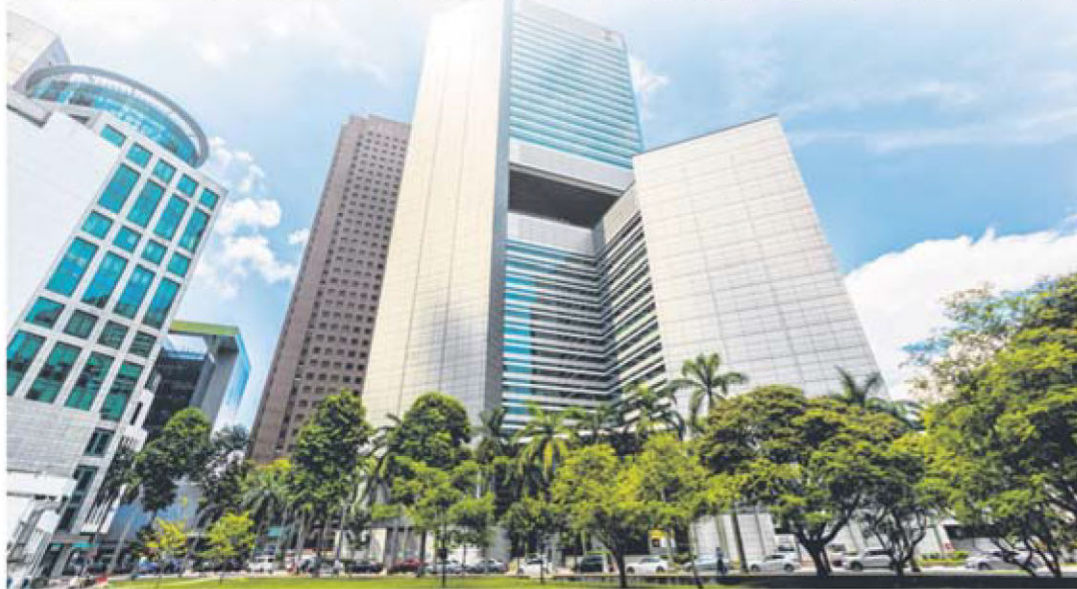
位于安顺路80号的富士施乐大厦重新发展项目获得绿色建筑认证的最高荣誉，是首个获得白金超低碳能耗的私宅项目。（城市发展提供）
