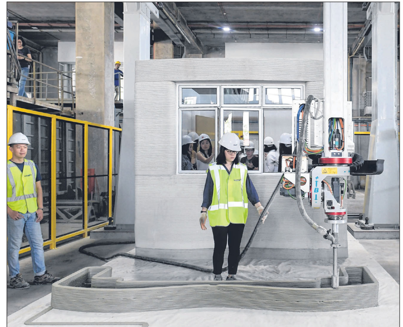
PERLUASKAN KEUPAYAAN: Pencetak konkrit 3D yang terletak di Institut Kajian Bangunan HDB di Woodlands berupaya mencetak komponen yang bersaiz sehingga sepanjang 9 meter, seluas 3.5 meter dan setinggi 3.8 meter. – Foto BH oleh ALPHONSUS CHERN
