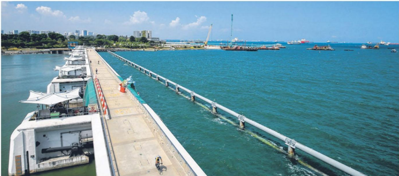
遇到涨潮和庞大雨势的情况，滨海堤坝的水泵会把滨海蓄水池的水抽出来排入海里，好让在市中心的降雨能排入滨海蓄水池。为了应对海平面上升带来的影响，我国将在滨海堤坝对面建造多一个水泵房。（叶振忠摄）
