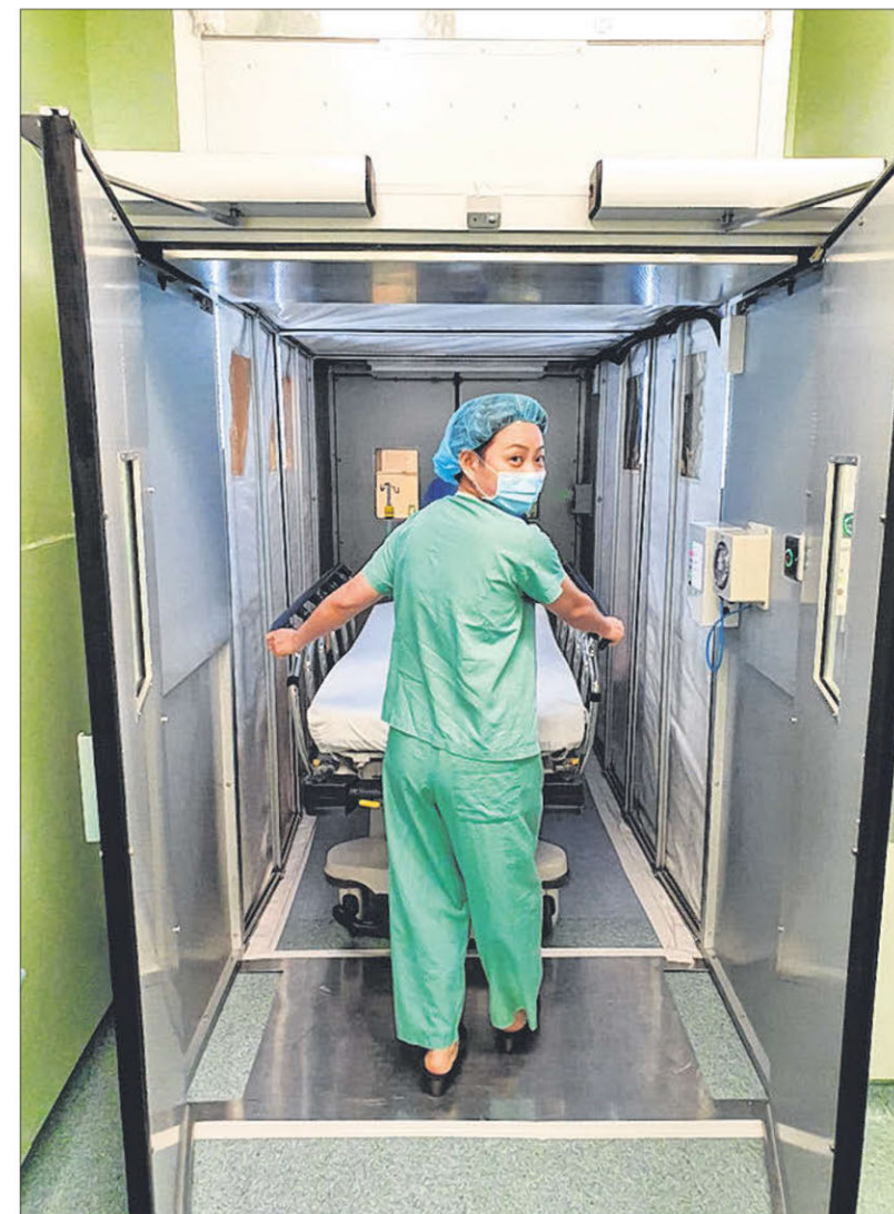
▲ 移动负压隔离间有两道门，并采用非接触式开门装置。医护人员进出病房时，流入隔离间的污染空气会被过滤和净化，然后循环回到病房内。（新加坡中央医院提供）
