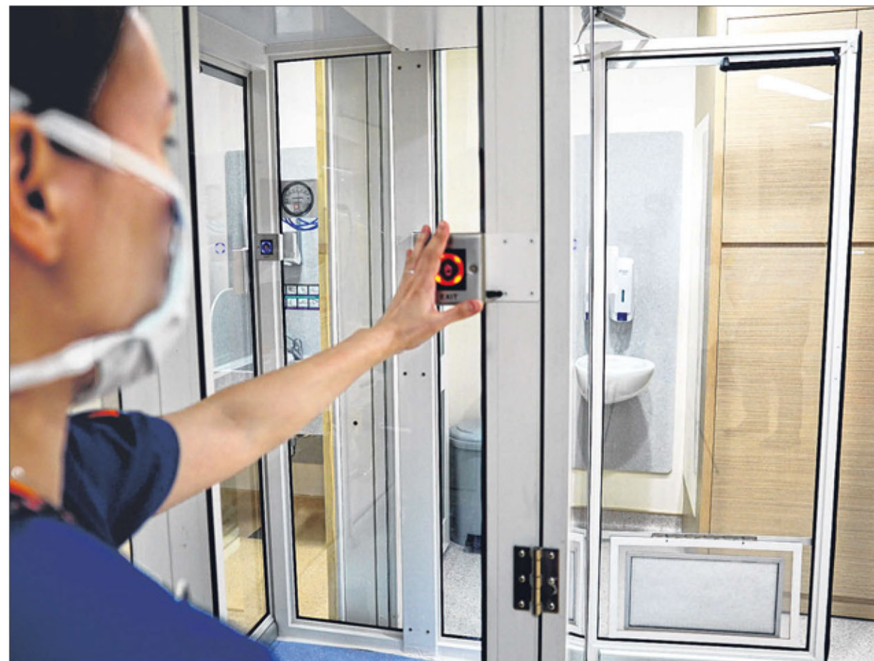
▲ 移动负压隔离间有两道门，并采用非接触式开门装置。医护人员进出病房时，流入隔离间的污染空气会被过滤和净化，然后循环回到病房内。（新加坡中央医院提供）
