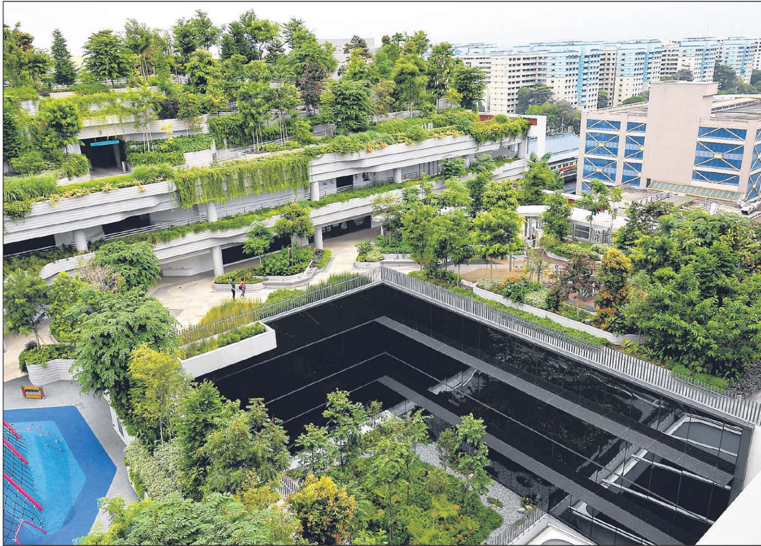
BUMBUNG HIJAU: Kompleks Kampung Admiralty setinggi 11 tingkat mempunyai bumbung bersepadu yang dilengkapi taman masyarakat, kawasan bercucuk tanam dan kawasan takungan air hujan di aras enam hingga sembilan. – Foto BH oleh KHALID BABA
