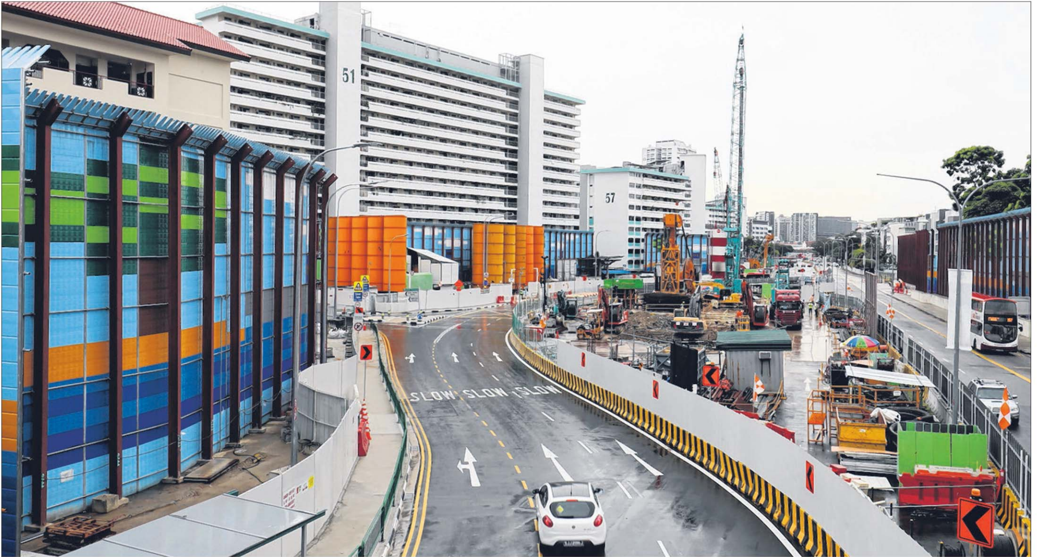
新款的隔音屏上方设有弯曲45度的锯齿状设计，声波可往三个不同的方向折射，不仅能降低工地噪音30%，隔音范围也扩大两倍。（林泽锐摄）
