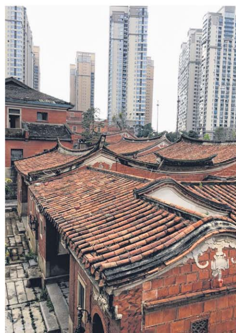
高楼围绕下的晋江五店市闽南传统街区。
