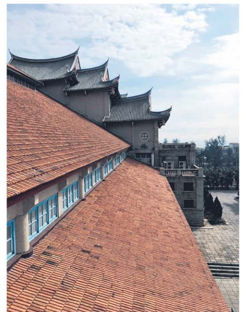
厦门大学建南大礼堂屋顶：伸手可及的“嘉庚瓦”。
