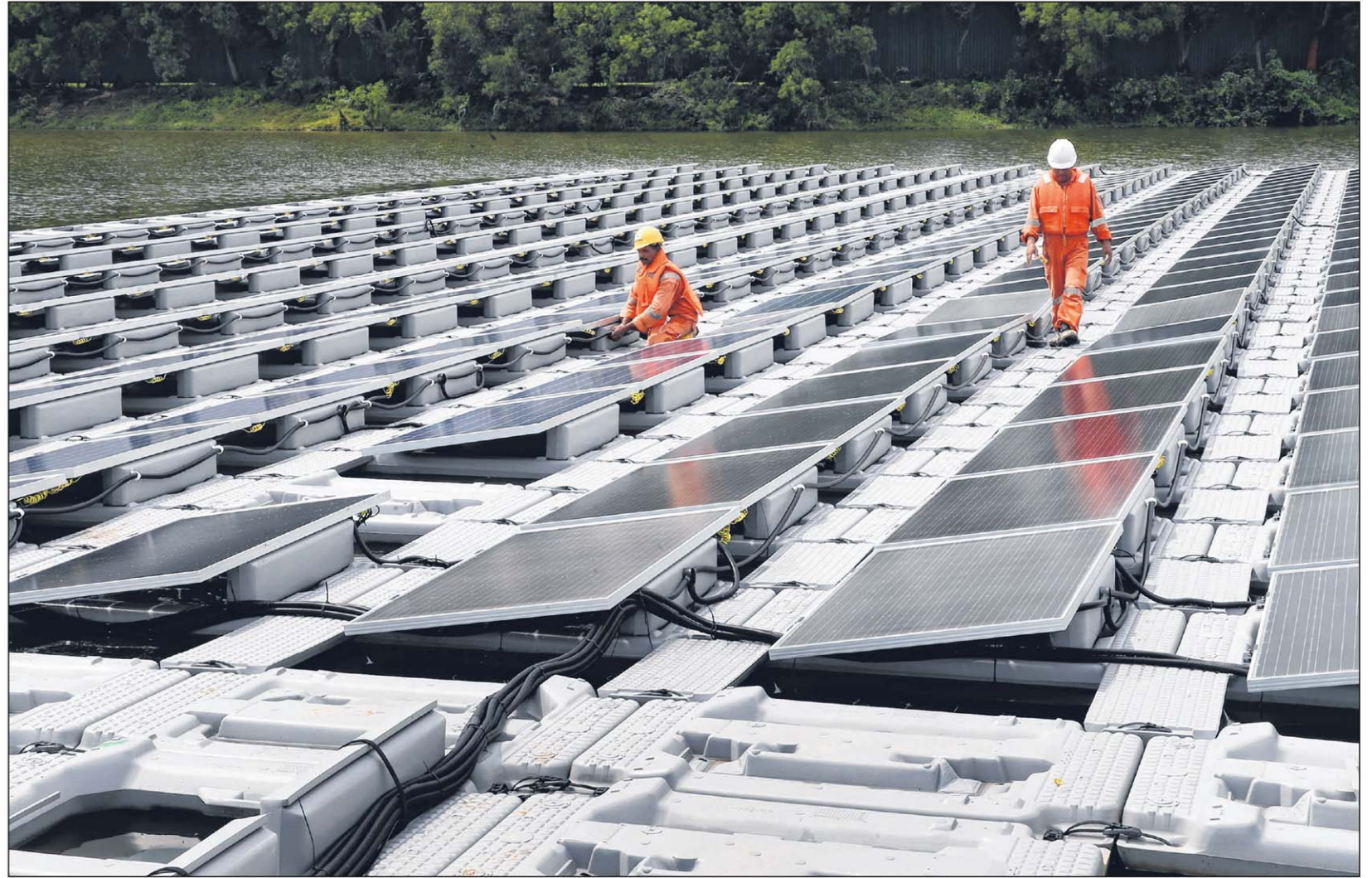
TENAGA BAGI MASA DEPAN: Dua pekerja berjalan di tapak uji sel fotovoltan kuasa suria di Kolam Air Tengah. Tapak uji terapung terbesar di dunia itu bakal digunakan bagi menguji keberkesanan 10 sistem panel kuasa solar berbeza dalam tempoh enam bulan mendatang. – Foto THE STRAITS TIMES
